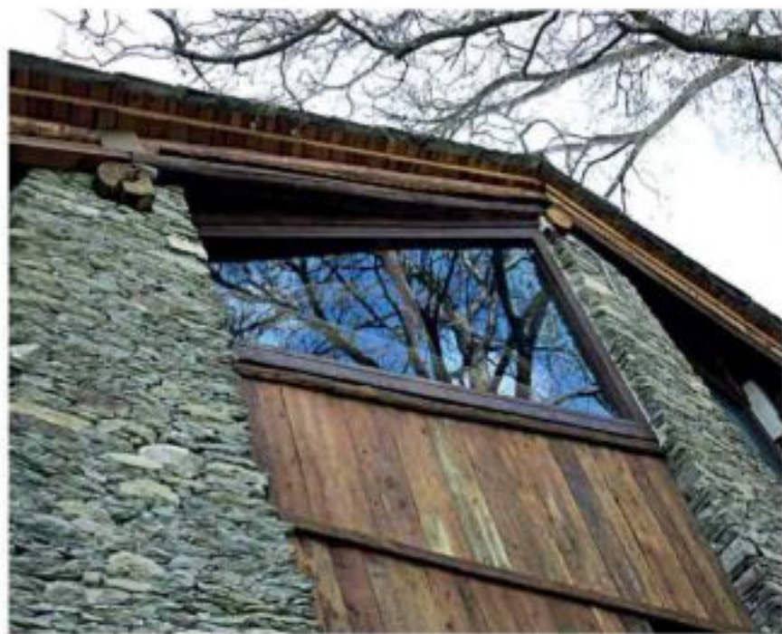
Le Colonne di pietra di Introd della facciata di Maison Bruil
